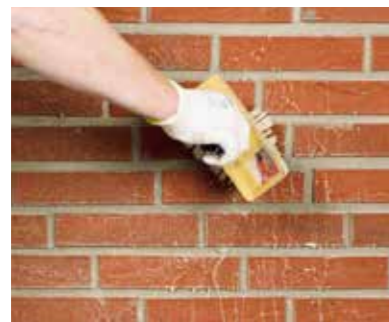
▲ 1. Grundieren Secco Hybrid-Grundierung aufspritzen oder -quasten
