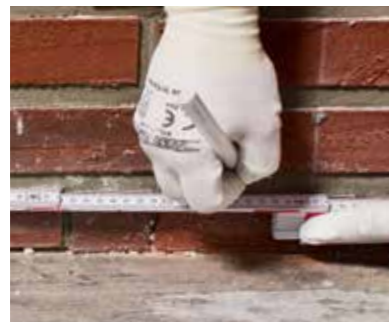
▲ 1. Ausmessen Anzeichnen der Bohrlöcher mit einem Achsabstand von max. 12,5 cm in waagerechter Fuge
