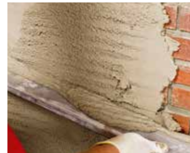
▲ 3. Auftragen und abziehen Secco Waterproof anwerfen und abziehen
