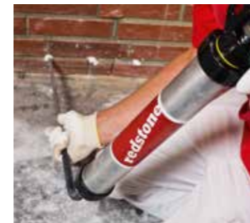
▲ 4. Verfüllen Bohrlöcher von hinten nach vorne verfüllen und direkt nach der Injektion mit Secco Waterproof verschließen
