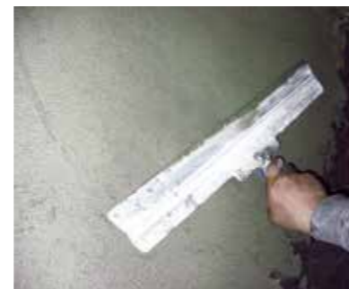
▲ 3. Auftragen Auftrag der Hybridabdichtung mit Glätter, Pinsel oder Spritzmaschine
