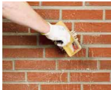
▲ 1. Grundieren Secco Hybrid-Grundierung aufspritzen oder -quasten
