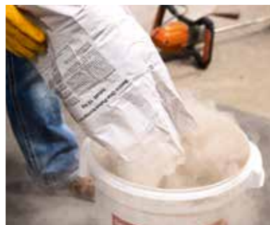
▲ 1. Einfüllen Die Flüssigkomponente in einen Eimer und nach und nach die Pulverkomponente dazugeben
