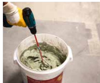
▲ 2. Anmischen Mischen der Komponenten, bis eine homogene Masse entsteht
