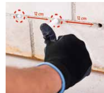
▲ 4. Einführen Die Sticks werden in das Bohrloch eingeschoben
