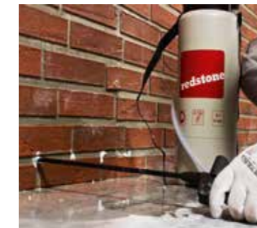
▲ 5. Alternativ Verfüllung mithilfe der Secco Injektionspumpe
