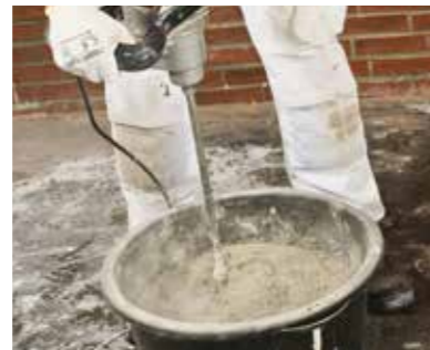
▲ 2. Anmischen Secco Waterproof anrühren
