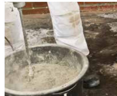
▲ 3. Anrühren Secco Due zur entsprechenden Konsistenz (Mörtel, Spachtel, Schlämme) einquirlen
