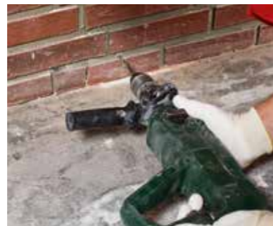
▲ 2. Bohren Bohrungen an den Markierungen durchführen und anschließend von Bohrstaub befreien (ausblasen)
