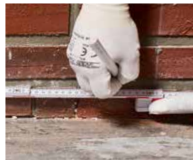
▲ 1. Ausmessen Anzeichnen der Bohrlöcher mit einem Achsabstand von max. 12 cm im Wandbildner
