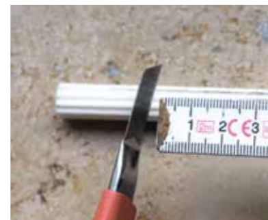
▲ 3. Ablängen Die Secco Horizontalsperren-Sticks werden auf die entsprechende Länge gebracht (Ablängen gem. Vorgaben TM)
