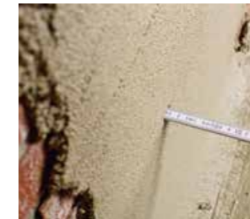
▲ 5. Messen Kontrolle der Schichtdicke: Mindestschichtdicke = 1 cm
