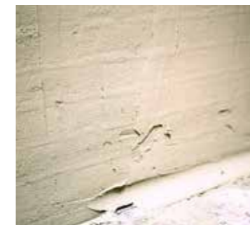
▲ 4. Hohlkehle profilieren Ausbilden der Hohlkehle aus Secco One
