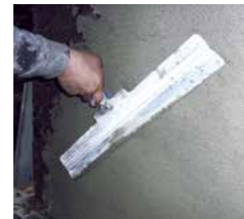
▲ 4. Aufbringen Secco Due aufspachteln oder -quasten
