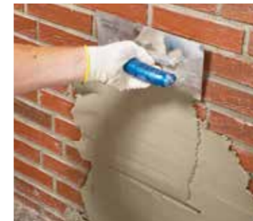
▲ 4. Aufziehen Alternativ aufziehen mit dem Glätter
