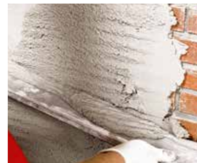
▲ 3. Abziehen Secco Activepor abziehen
