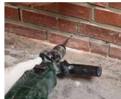
▲ 2. Bohren Bohrungen mit einem Durchmesser von 12 mm an den Markierungen durchführen
