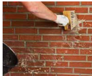
▲ 1. Grundieren Secco Hybrid-Grundierung aufsprühen oder -quasten
