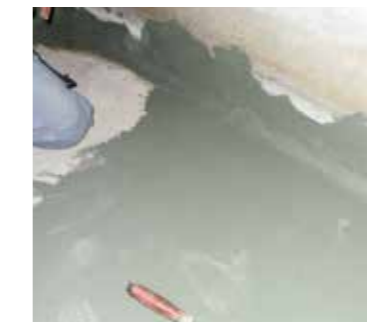
▲ 5. Abdichten von Bodenplatten Spachteln, Ausgleichen und Instandsetzen von Betonböden und Estrichplatten
