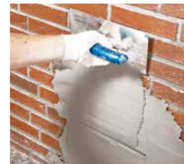
▲ 4. Aufziehen Alternativ aufziehen mit dem Glätter
