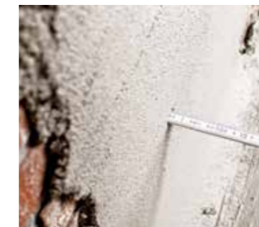
▲ 5. Messen Kontrolle der Schichtdicke: Mindestschichtdicke = 2 cm
