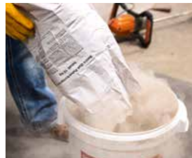
▲ 2. Einfüllen In die entsprechende Literzahl Anmachwasser einbringen
